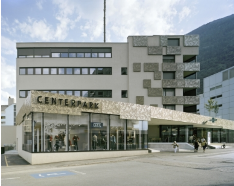
Auf der Nordseite umschliesst das Erdgeschoss den Bestandsbau des Swisscom Gebäudes.
