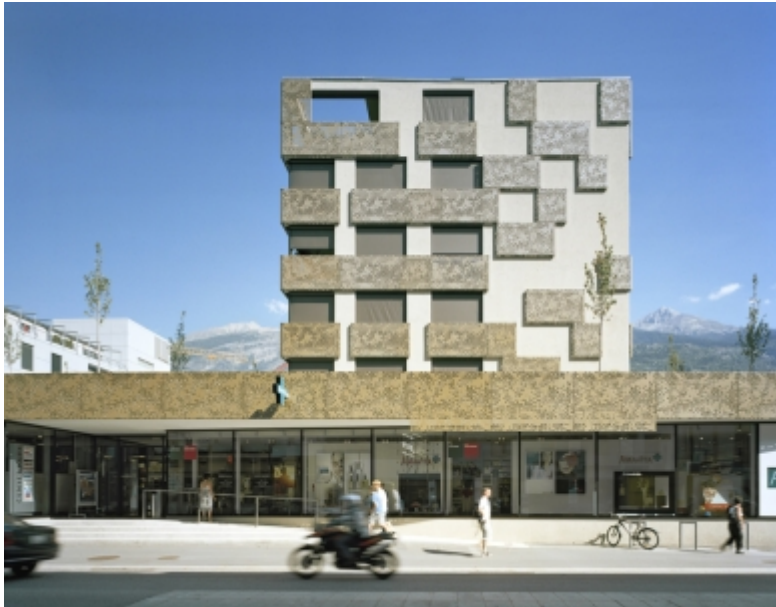
Ansicht von der Kantonsstrasse: Das Einkaufszentrum bildet den Sockel für den fünfgeschossigen Wohnungsbau.
